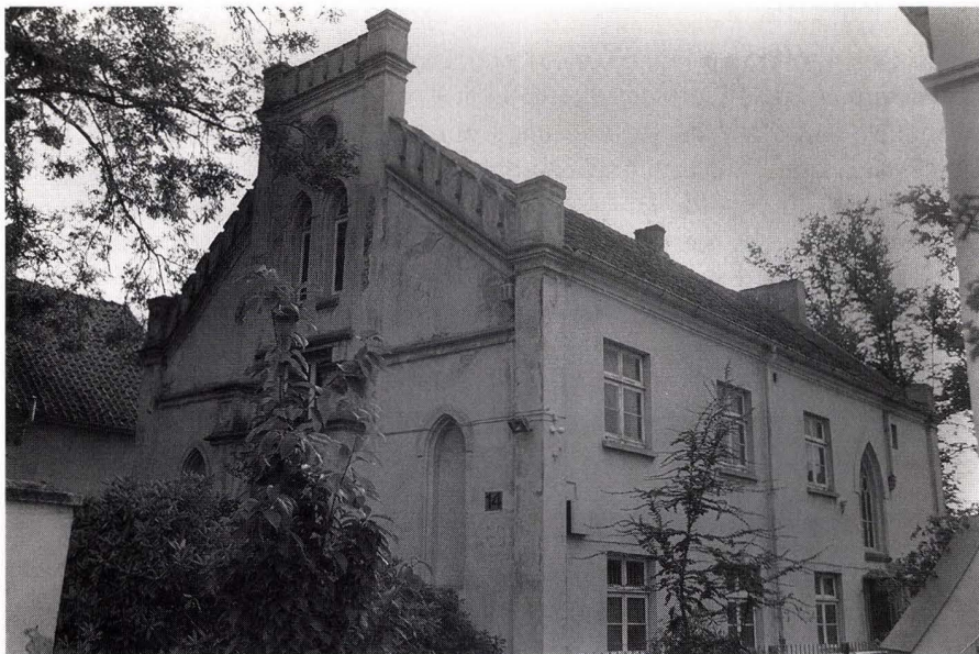
Die ehemalige Baptistenkapelle und zukünftige Synagoge Wilhelmstraße 17 vor der Erneuerung. Nord- und Ostseite im August 1991.
