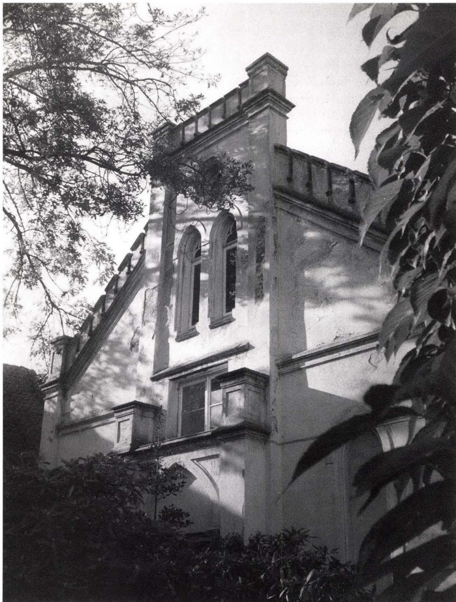
Die ehemalige Baptistenkapelle und spätere MTA-Schule Wilhelmstraße 17 vor der Restaurierung und Umnutzung zur neuen Synagoge. Gesehen von Osten im Sommer 1991.
