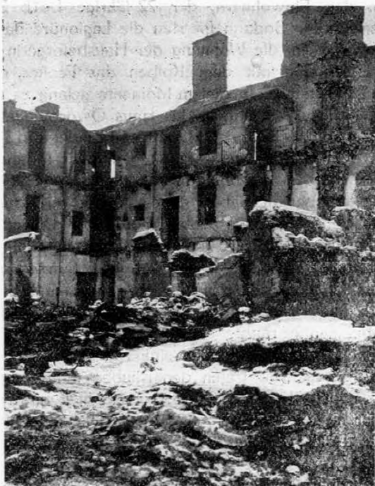
Durch Feuer zerstörte Häuser.
