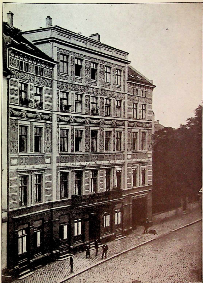
21. Haus Spohrstraße 44, Kassel Sgraffittomalerei nach 1880 (Photographie)
