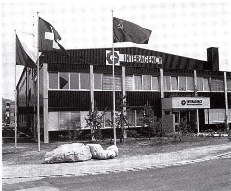
Sowjetische Maschinen für die Schweiz: Gebäude der Firma Interagency Zürich
